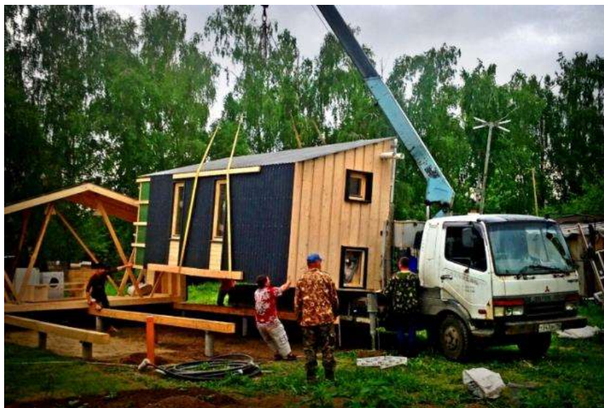
Рис.2. Дубльдом в процессе установки
